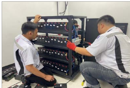
ภาพ : การติดตั้งชุดแบตเตอรี่ที่อยู่ภายในตู้ แบตเตอรี่และต่อสายไฟของตู้แบตเตอรี่
