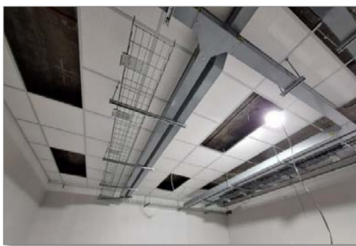
ภาพ : การติดตั้งผ้าเพดานสำหรับห้อง คอมพิวเตอร์แม่ข่ายที่ทำการปรับปรุง
