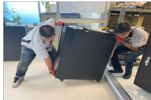
ภาพ : การเคลื่อนย้ายอุปกรณ์ประกอบสำหรับ ใช้งานกับ UPS (เดิม) เพื่อเตรียมติดตั้ง
